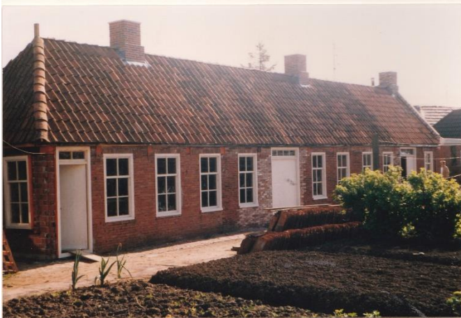
1984m restauratie van het armenhuis aan de Oude Gang.
